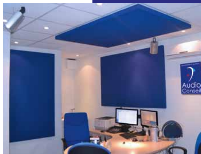
Cabine avec équipement en bafles surround
